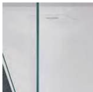
○ Spojení sklo na sklo, pomocí lepení (nelze v šikmém úhlu)
