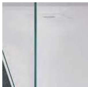
Spoj sklo - sklo pomocí lepení (nelze v šikmém úhlu)
